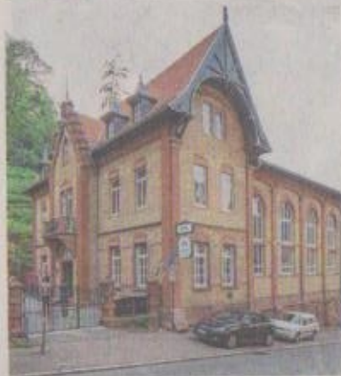
Nach der Renovierung ist die „Villa“ wieder Anlaufstelle für Jugendliche.
